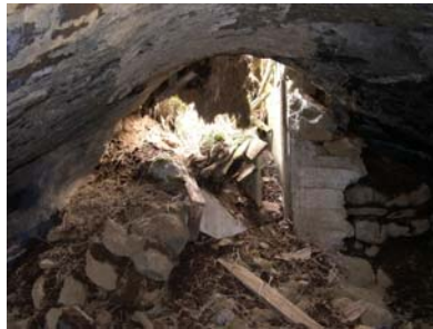
Inngangurinn. Sést í steypa vegginn.
