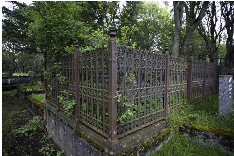
Innflutt járnsteypt grindverk á steinsteyptri undirstöðu umhverfis reit nr. M 522.
