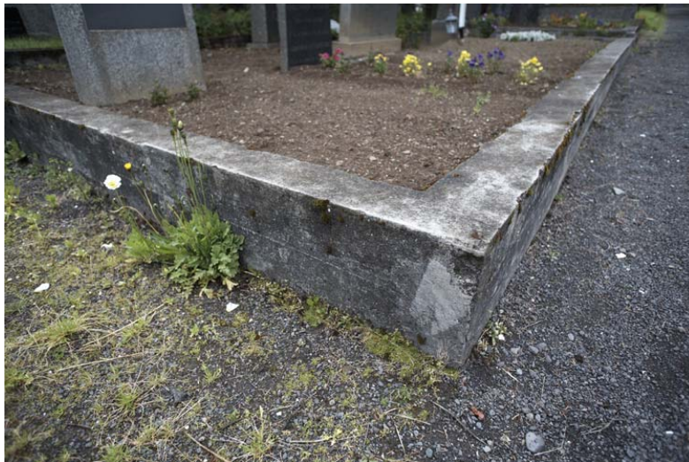
Kringum reit nr. K 516 er lágur steinsteyptur bakki.
